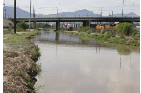
Unlined Franklin Canal above Ascarate Lake, El Paso, TX
